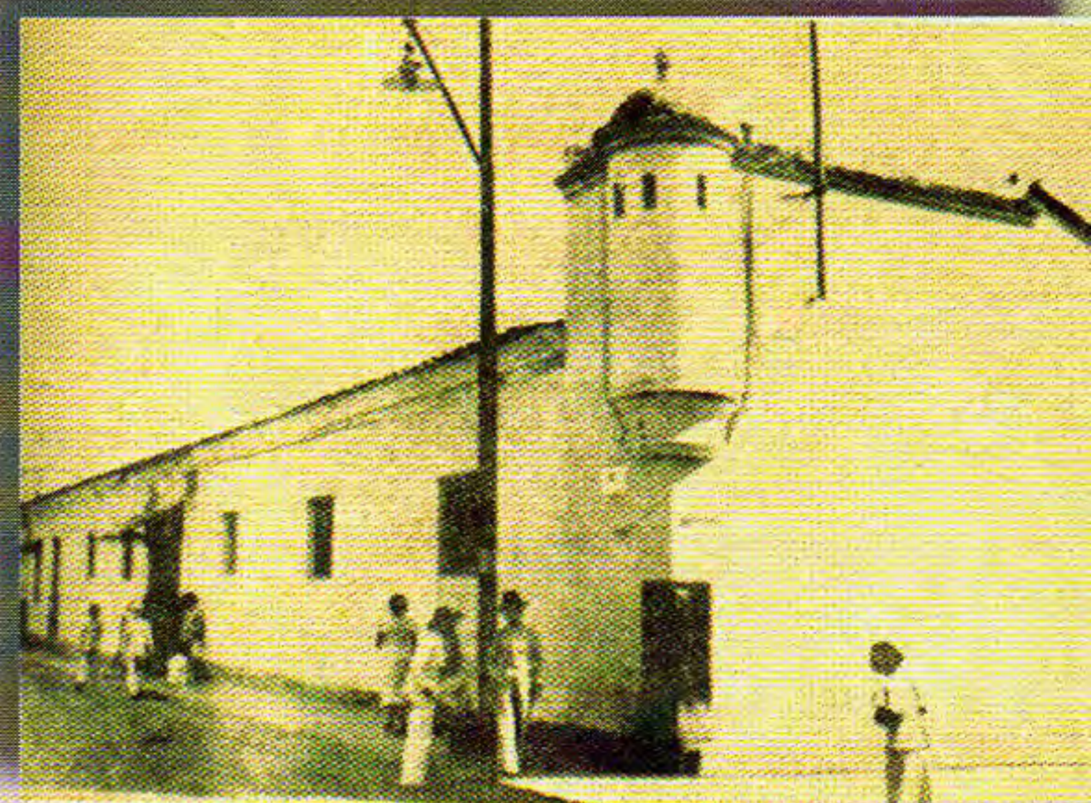
Parte exterior de la tétrica prisión
